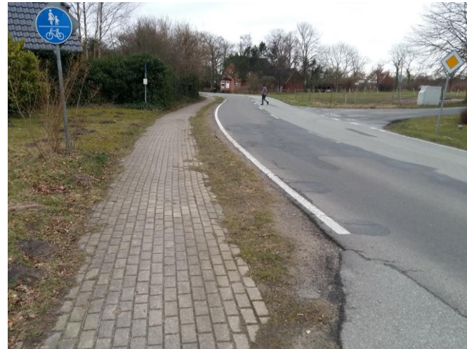
Die Landstraße L 236 – „Hauptstraße“ - Bereich des Rad –und Fußweges
